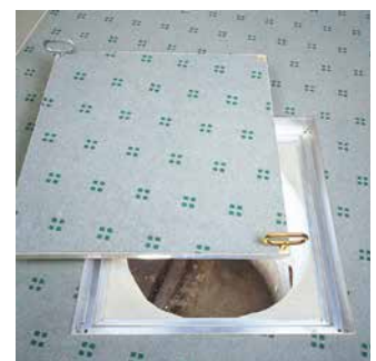
Réalisation dans un bureau avec du revêtement sol souple
